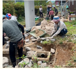
集水のための土溝づくり
