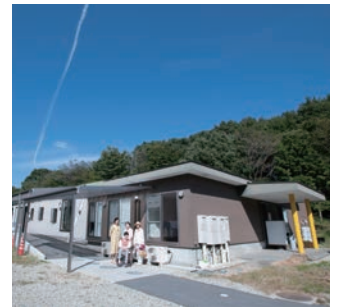
元室内プールを大改装
