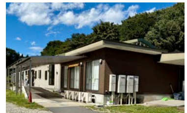
元室内プールを大改装しました
