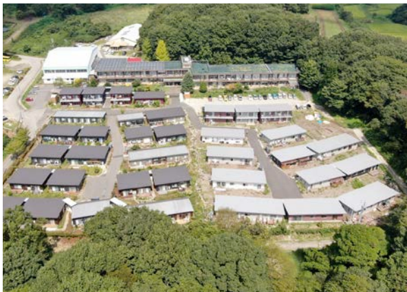
那須まちづくり広場全景
